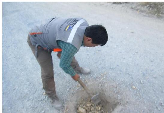
Figura 33. Extracción del material de subrasante del tramo Yaca – Soccos
