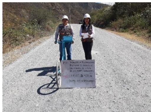
Figura 118. Evaluación del índice de rugosidad del tramo I.
