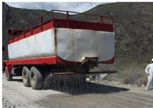
Figura 113. Riego del afirmado del tramo II.
