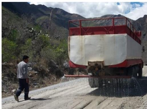
Figura 112. Riego del afirmado del tramo I.
