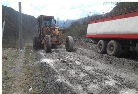
Figura 111. Homogenización del afirmado con cal.
