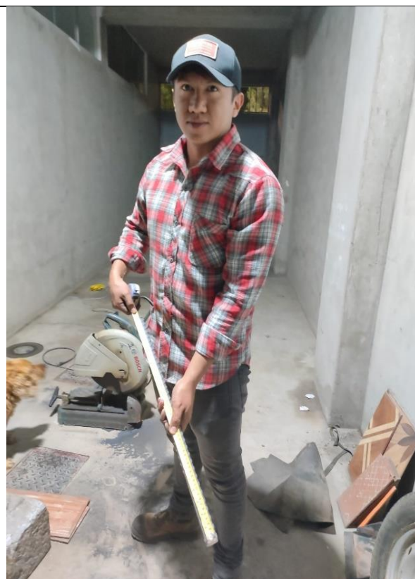
En la imagen se observa una varilla de 1" ya cortada con 65 cm de longitud.
