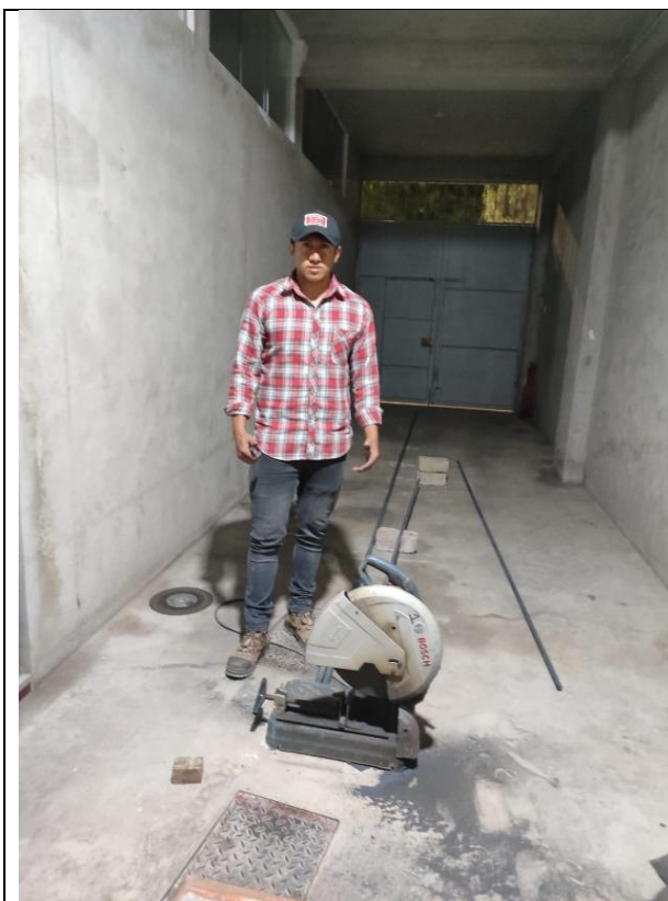
Cortado de las Barras de acero con Tronzadora
