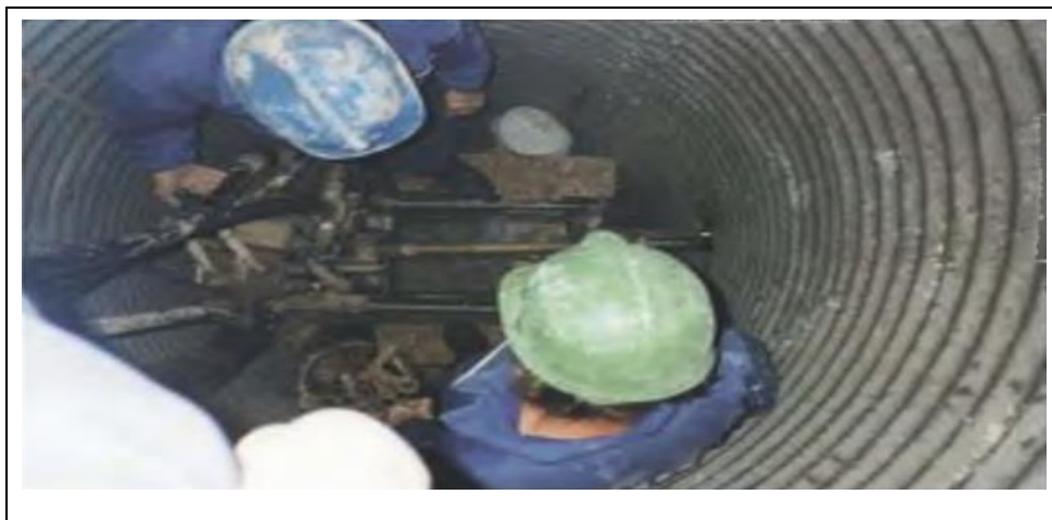
Figura 60 Realización de pozos.
