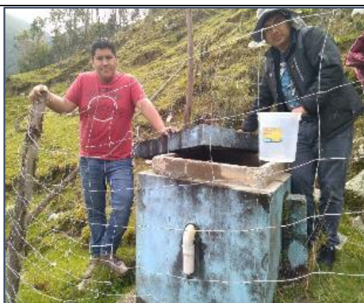
Fotografía. 45: Midiendo el caudal de la fuente de agua en la cámara rompe presión
