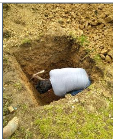
Fotografía. 42: Excavación de pozo para realizar la prueba de infiltración, para análisis de percolación de aguas residuales.
