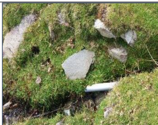
Fotografía. 14: Vista de tubería descubierto en línea de conducción de agua potable Anchicha.
