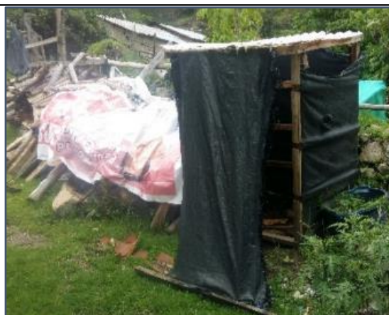
Fotografía. 23: Vista de letrina domiciliaria, construido de manera improvisada
