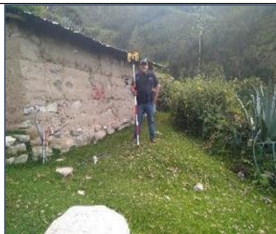
Fotografía. 29: Levantamiento topográfico de la línea de conducción.
