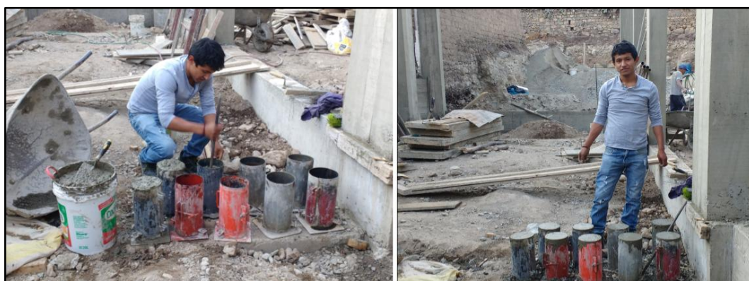
Imagen 5. 2 Extracción de testigos de concreto de las columnas
