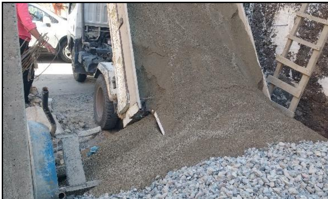
Llegada de material agregado fino a obra.
