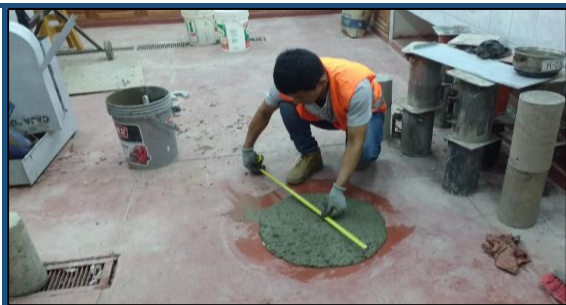
Medicion del diametro de expansion D1, d2 del concreto autocompactante
