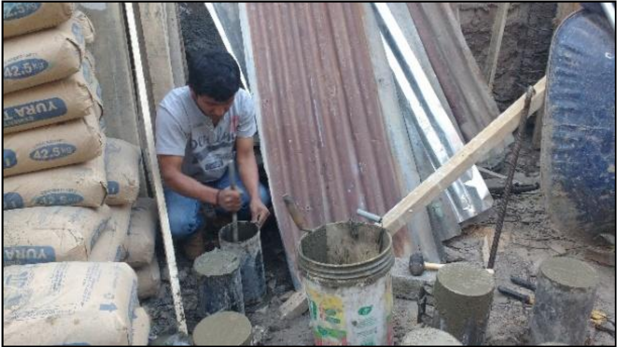
Extracción de testigos de concreto de una vivienda sin dirección técnica.
