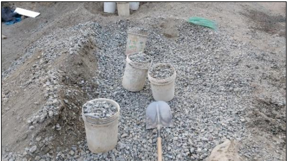
Material agregado grueso en obra.
