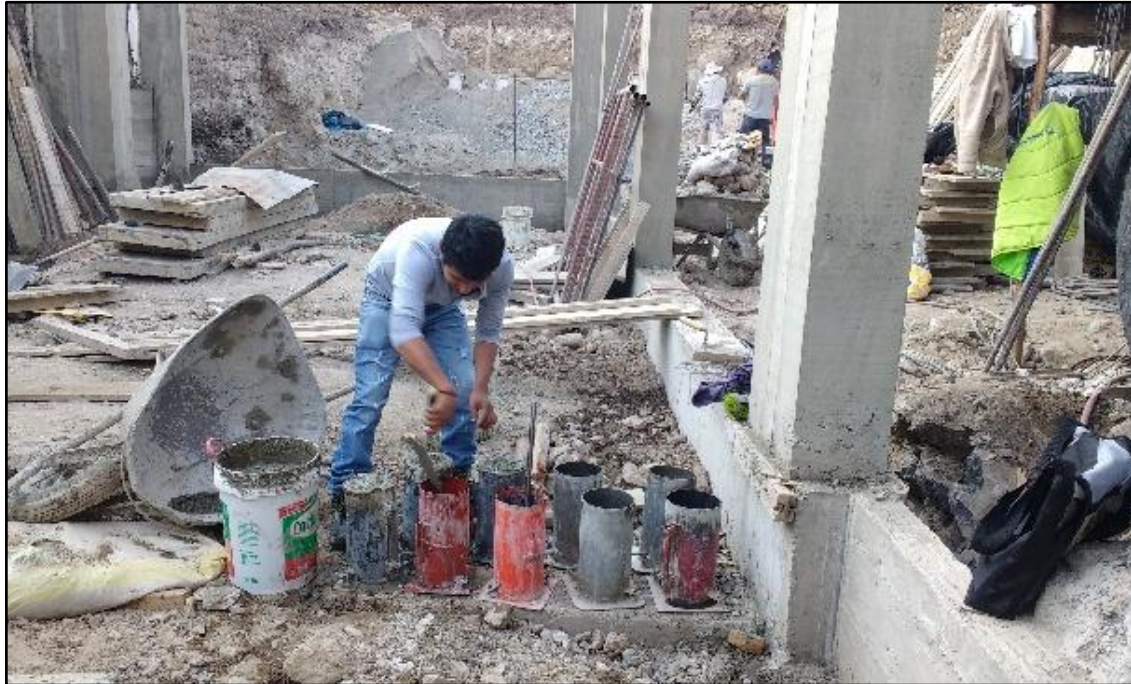
Extracción de testigos de concreto de una vivienda sin dirección técnica.
