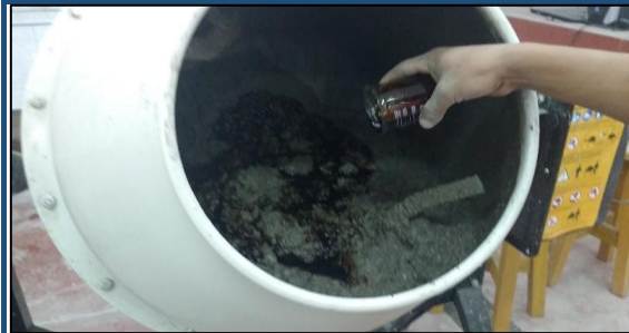
Echamos el aditivo superplastificante para obtener el concreto autocompactante
