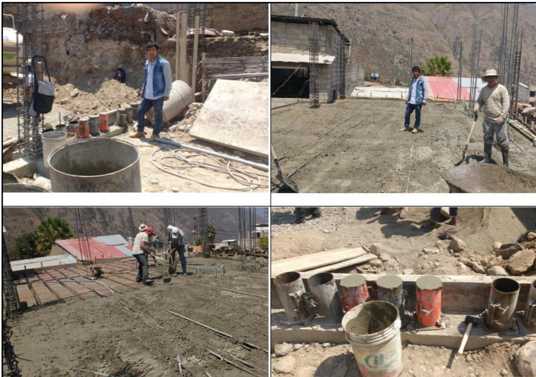
Imagen 5. 3 Extracción de testigos de concreto en losa e inspección de la elaboración del concreto en obra.
