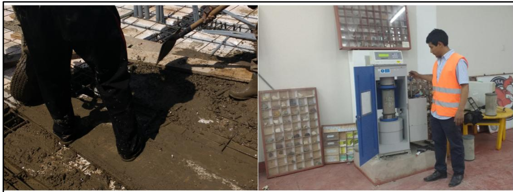
Imagen 5. 5 Encofrado de las columnas, asi como también extracción de testigo de concreto
