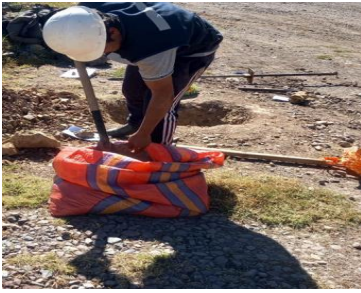
Figura 19. Excavación manual de calicatas
