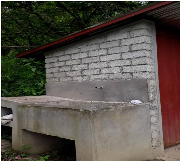
Fotografía 21: vista de letrinas y piletas en domicilios.
