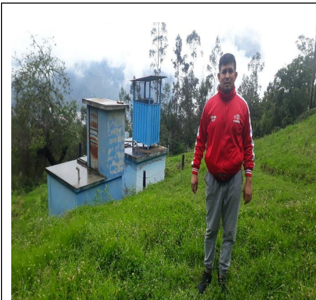
Fotografía 29: vista de reservorio de la localidad de Umaccata.
