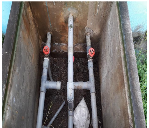
Fotografía 16: vista de caja de válvulas de reservorio nuevo.
