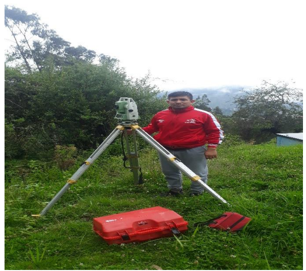
Fotografía 28: levantamiento topográfico del sistema de agua potable de la localidad de Umaccata.
