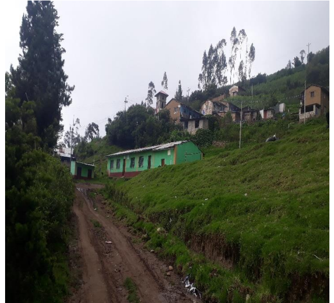
Fotografía 2: vista de calle principal para ingreso hacia Umaccata.
