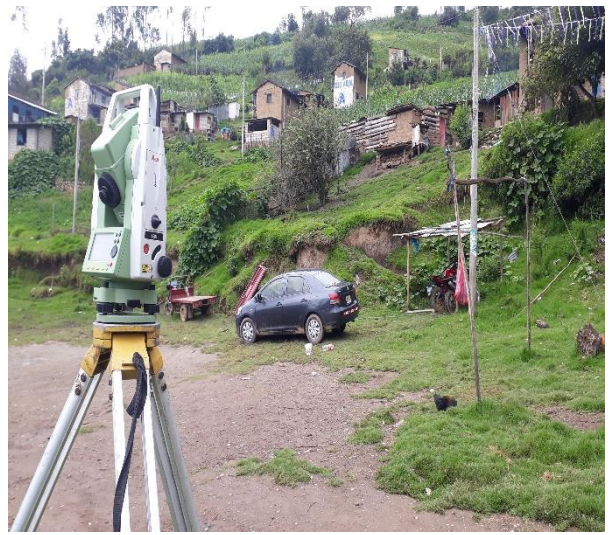
Fotografía 36: vista de equipo topográfico.
