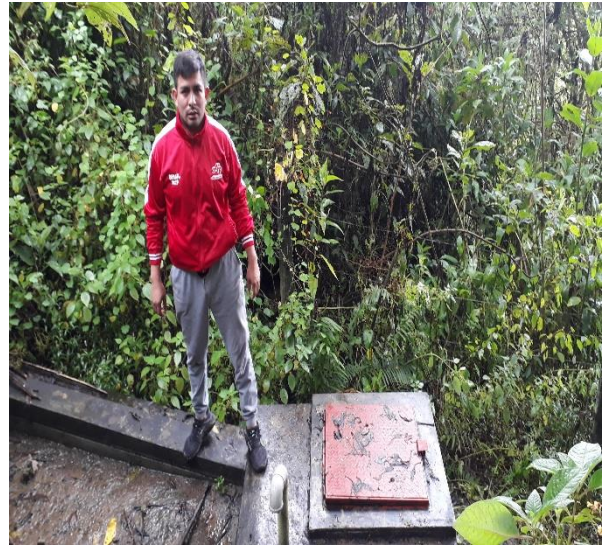
Fotografía 10: vista captación de Umaccata.
