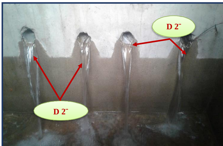
Figura 19. Cuatro orificios de entrada de 2"- captación Canterian Fuente: Elaboración propia.
