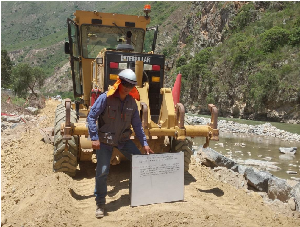
Se observa a la maquinaria motoniveladora realizando la conformación del terraplén por capas
