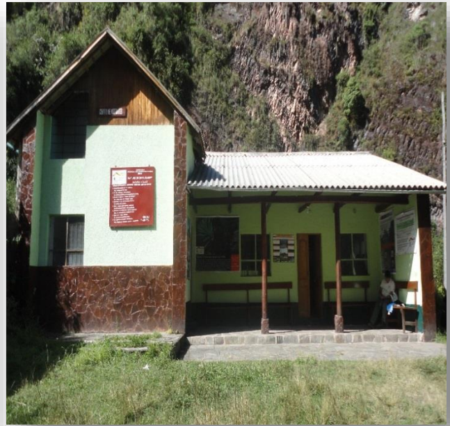
Puesto de control
