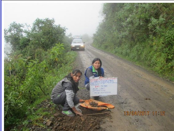
Km 9+000 : ancho de la via = 2.90 m, espesor de afirmado 0.08 m
