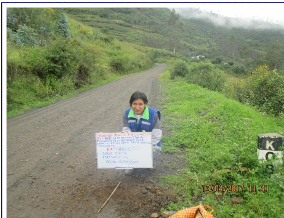
Km 8+000 : ancho de la via = 4.20 m, espesor de afirmado 0.10m
