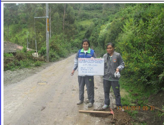
Km 14+000 : ancho de la via = 4.20 m, espesor de afirmado 0.21m
