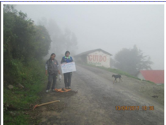
Km12+000 : ancho de la via = 3.10 m, espesor de afirmado 0.18m
