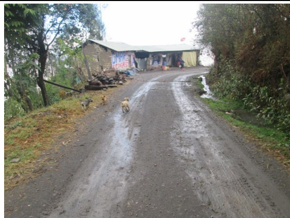
Foto 11: Daños a la calzada ocasionado por canales de riego
