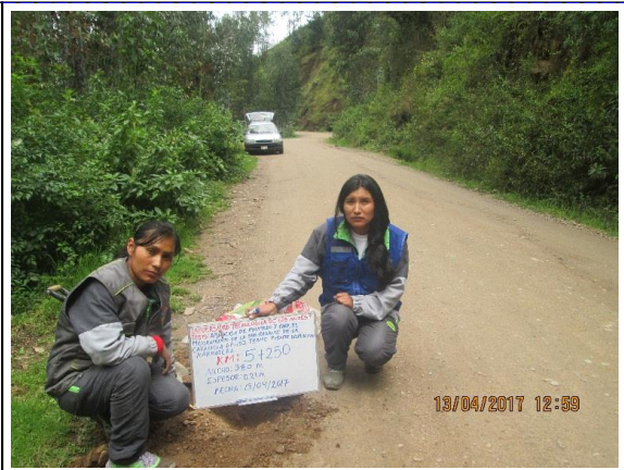
Km 5+250 : ancho de la vía = 3.80 m, espesor de afirmado 0.21m
