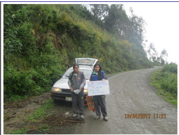
Km 8+750 : ancho de la via = 3.60 m, espesor de afirmado 0.14m
