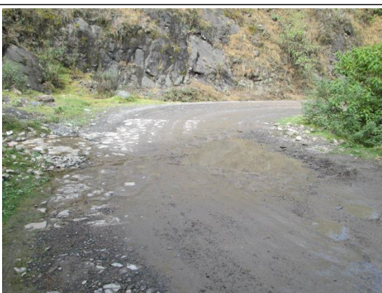
Foto 06: Baden en mal estado, visible formación de charcos de agua.
