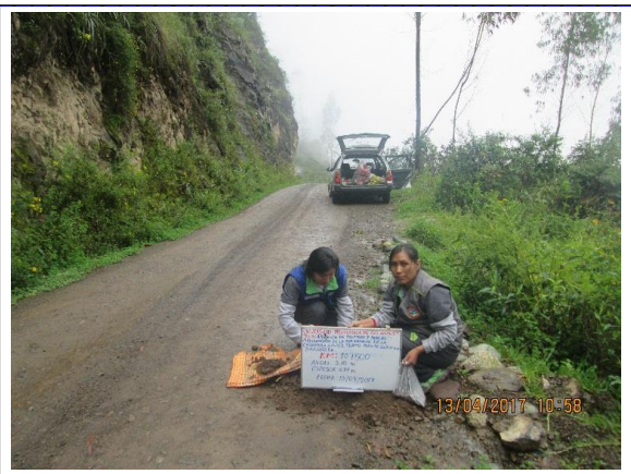
Km10+500 : ancho de la via = 3.10 m, espesor de afirmado 0.14m
