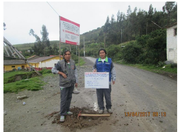
Km15+250 : ancho de la via = 4.30 m, espesor de afirmado 0.27 m
