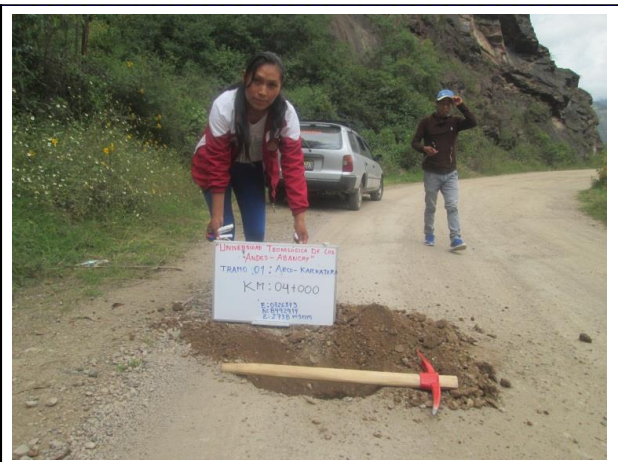
Km 4+000 : ancho de la via = 4.80 m, espesor de afirmado 0.28m
