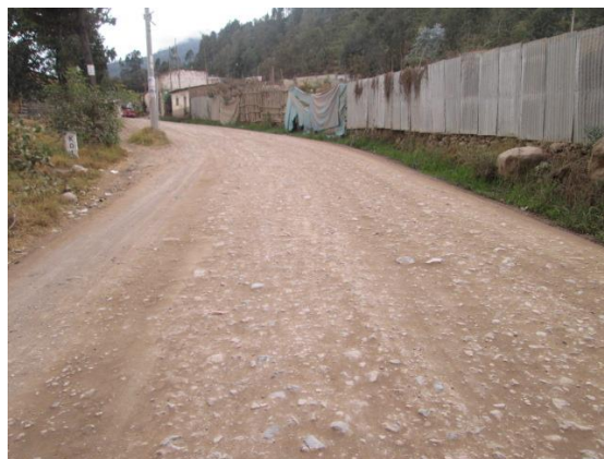
foto 02: km 1+000 plataforma con visible pérdida de material de afirmado.
