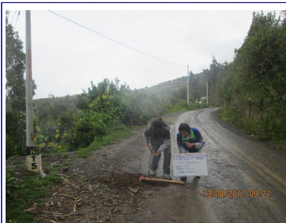
Km 15+000 : ancho de la via = 3.60 m, espesor de afirmado 0.16m
