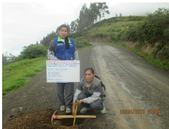
Km 16+000 : ancho de la via = 3.80 m, espesor de afirmado 0.10m
