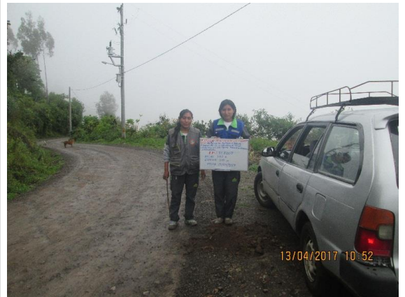
Km10+500 : ancho de la via = 3.10 m, espesor de afirmado 0.14m
