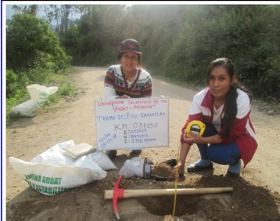
Km 3+000 : ancho de la via = 3.10 m, espesor de afirmado 0.28m
