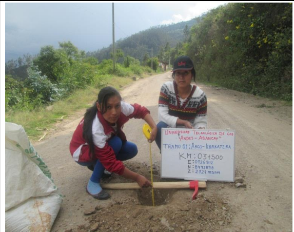
Km 3+500 : ancho de la via = 4.30 m, espesor de afirmado 0.27 m
