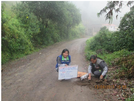
Km 10+250 : ancho de la via = 3.40 m, espesor de afirmado 0.09m
