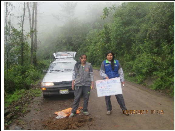
Km 8+750 : ancho de la via = 3.60 m, espesor de afirmado 0.14m
