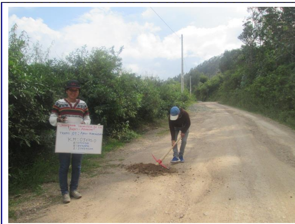
Km 3+750 : ancho de la via = 4.40 m, espesor de afirmado 0.32m
