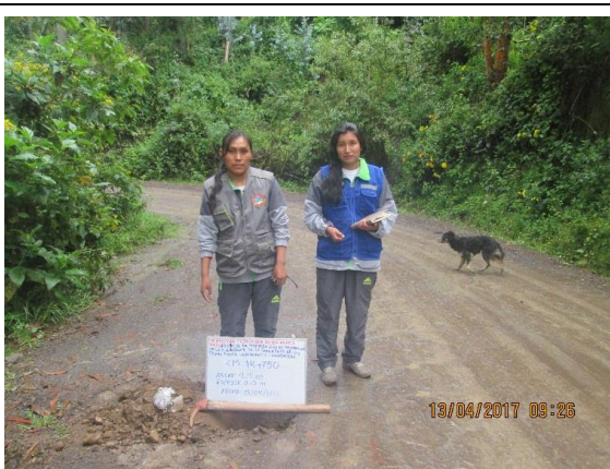
Km14+250 : ancho de la via = 3.80 m, espesor de afirmado 0.23m
