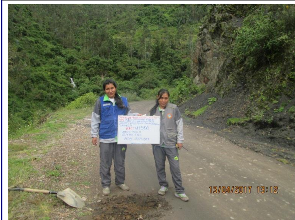
Km 3+750 : ancho de la via = 4.40 m, espesor de afirmado 0.32m
