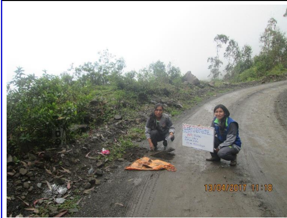
Km 8+000 : ancho de la via = 4.20 m, espesor de afirmado 0.10m
