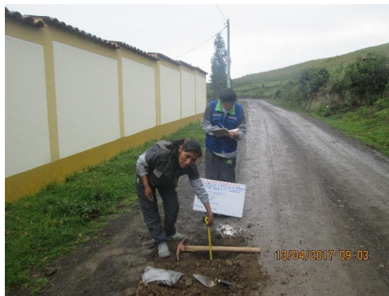
Km 15+500 : ancho de la via = 3.80 m, espesor de afirmado 0.10m
