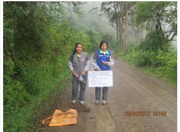
Km11+000 : ancho de la via = 3.90 m, espesor de afirmado 0.13 m
