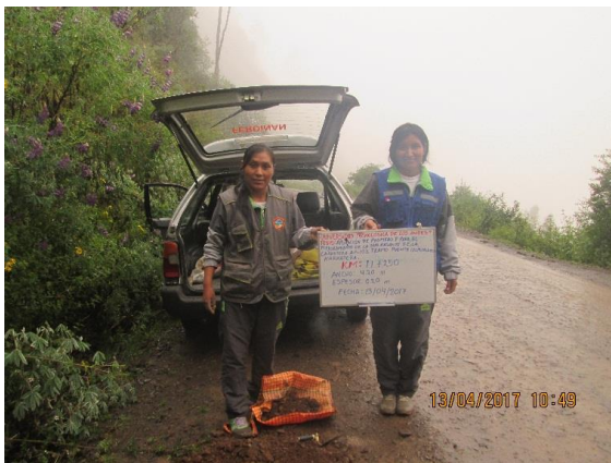
Km 10+750 : ancho de la via = 3.30 m, espesor de afirmado 0.21m
