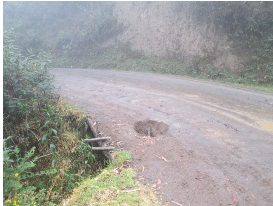
foto 33: Pontón con daños en la superficie
