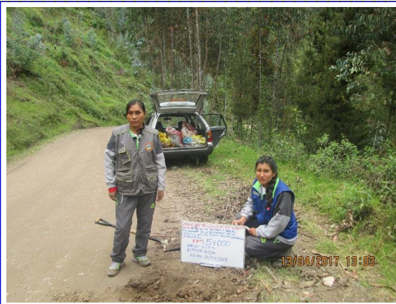
Km 5+000 : ancho de la vía = 4.00 m, espesor de afirmado 0.25m
