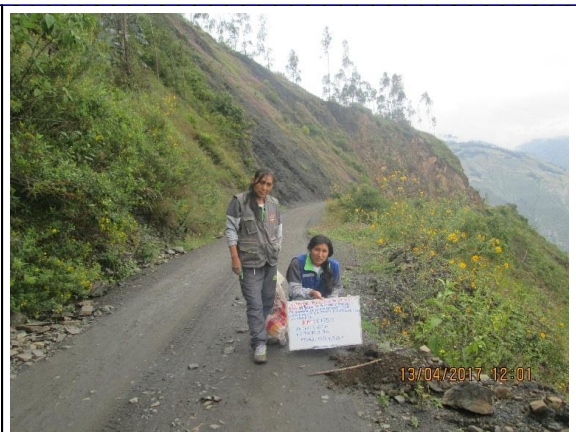
Km 6+750 : ancho de la via = 2.60 m, espesor de afirmado 0.14m
