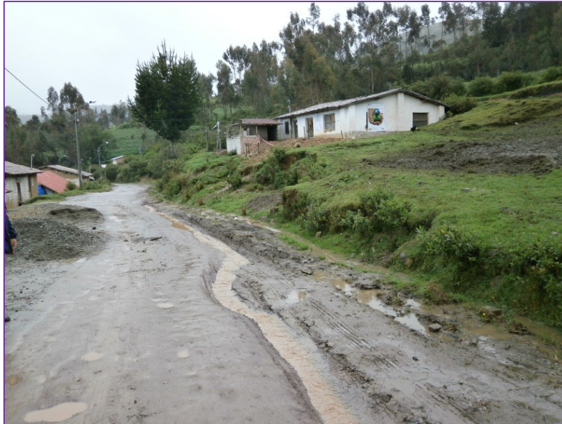
Figura 7. Diagnostico en la progresiva KM 0+400
