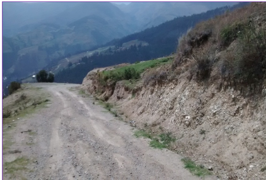
Fotografía 18. Camino vecinal en la progresiva KM 12+100
