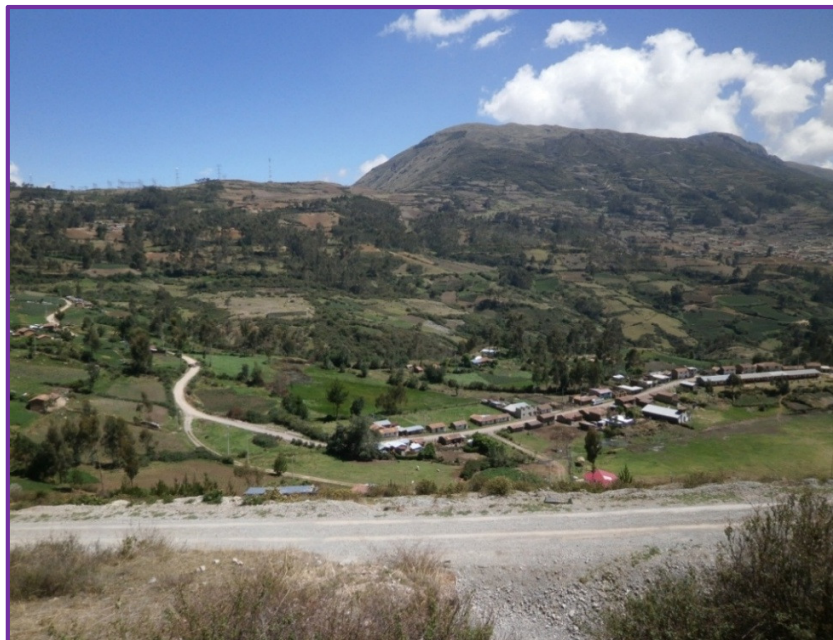
Fotografía 4. Camino vecinal en la progresiva KM 02+200 Fuente: Elaboración Propia
