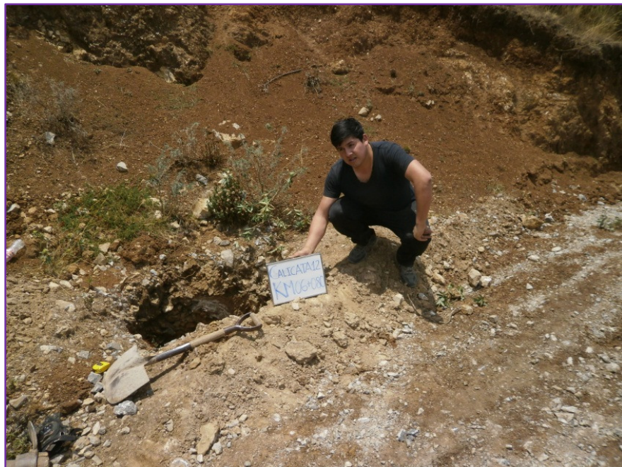
Fotografía 4. Calicata en la progresiva 06+080 Fuente: Elaboración Propia
