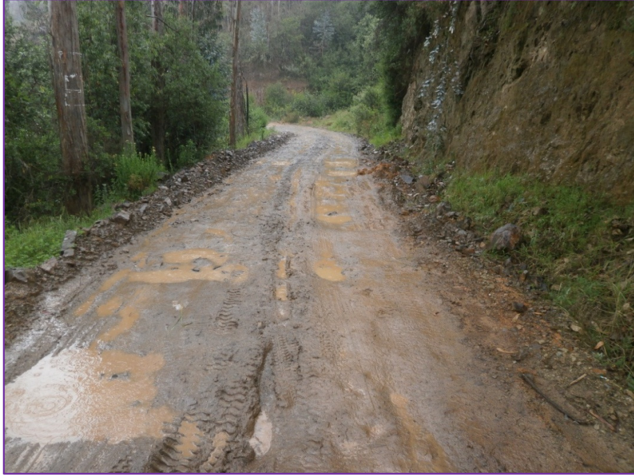
Fotografía 7. Camino vecinal en la progresiva KM 08+450 Fuente: Elaboración Propia
