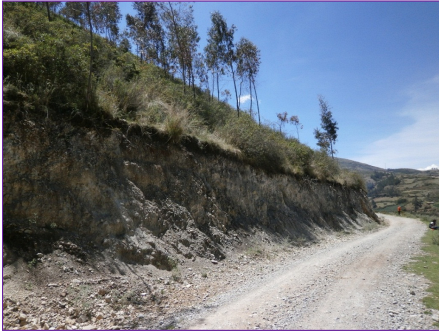
Fotografía 9. Camino vecinal en la progresiva KM 05+100 Fuente: Elaboración Propia
