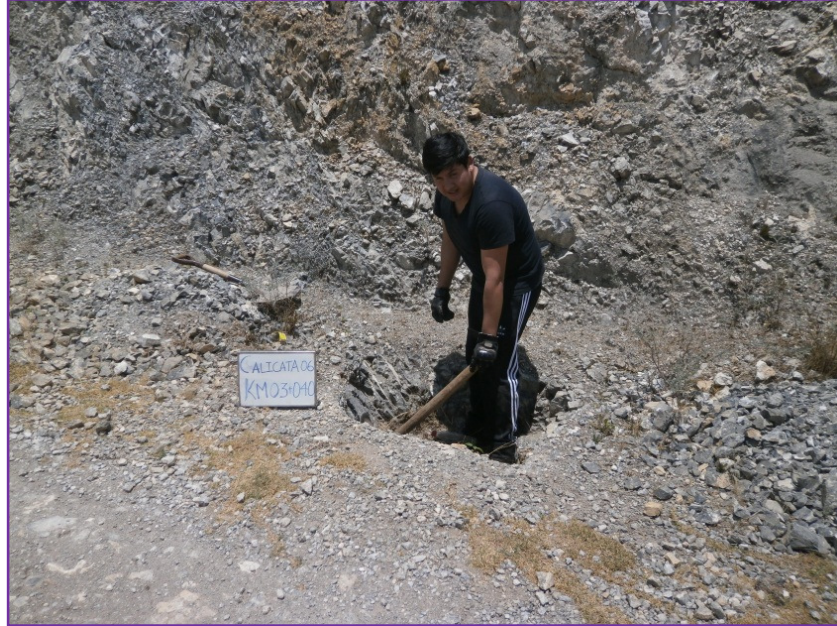
Fotografía 3. Calicata en la progresiva 03+040 Fuente: Elaboración Propia
