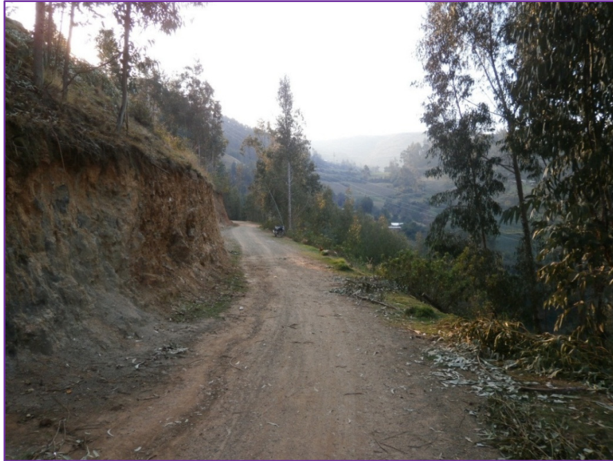
Fotografía 15. Camino vecinal en la progresiva KM 08+500
