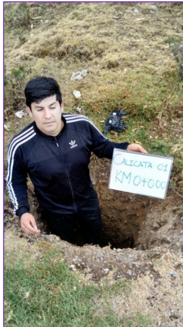
Fotografía 1. Calicata en la progresiva Km 0+000
