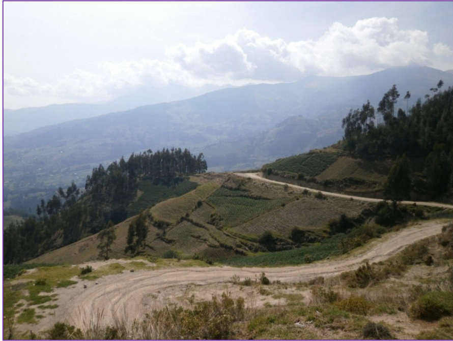
Fotografía 17. Camino vecinal en la progresiva KM 11+380
