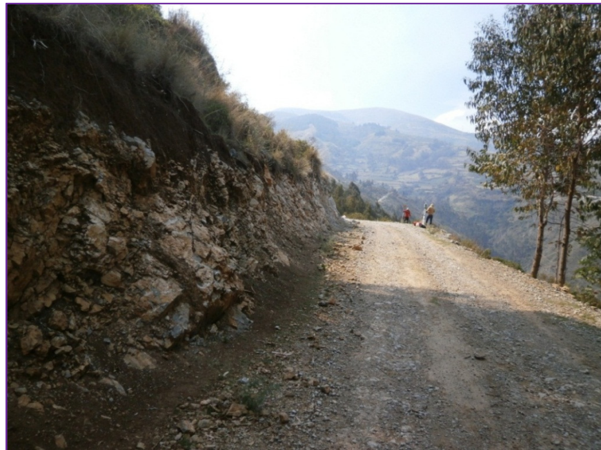
Fotografía 10. Camino vecinal en la progresiva KM 05+300 Fuente: Elaboración Propia
