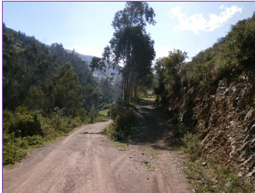
Fotografía 6. Camino vecinal en la progresiva KM 03+500 Fuente: Elaboración Propia
