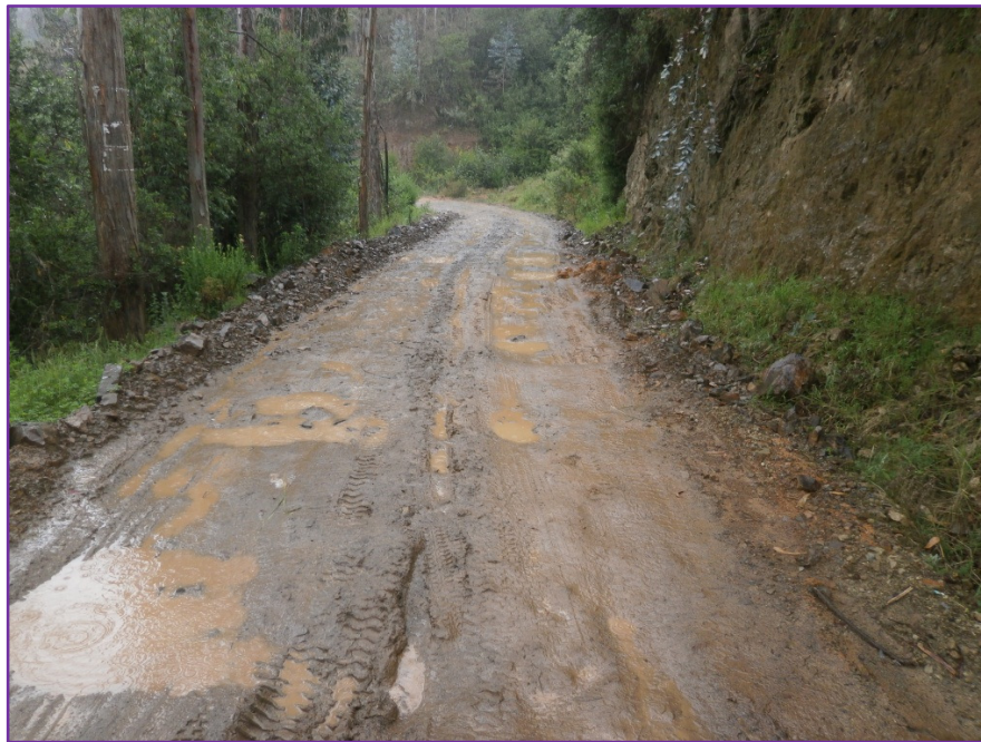
Figura 16. Diagnostico en la progresiva km 8+450.
