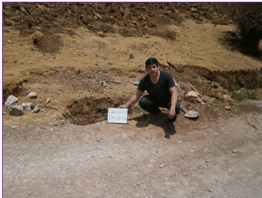
Fotografía 2. Calicata en la progresiva Km04+520
