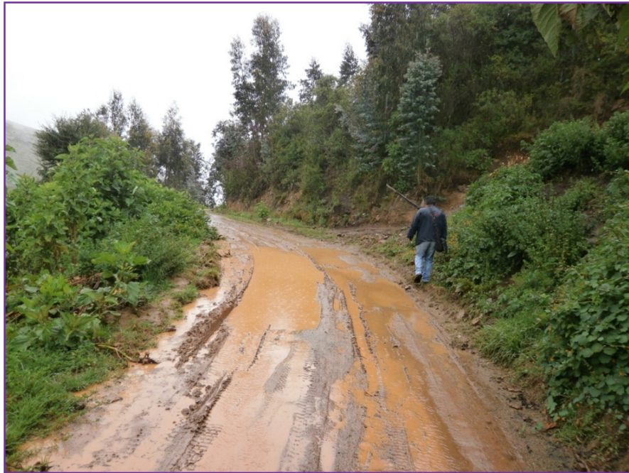
Fotografía 8. Camino vecinal en la progresiva KM 05+280 Fuente: Elaboración Propia
