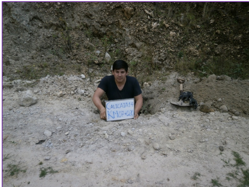
Fotografía 6. Calicata en la progresiva KM 07+020 Fuente: Elaboración Propia
