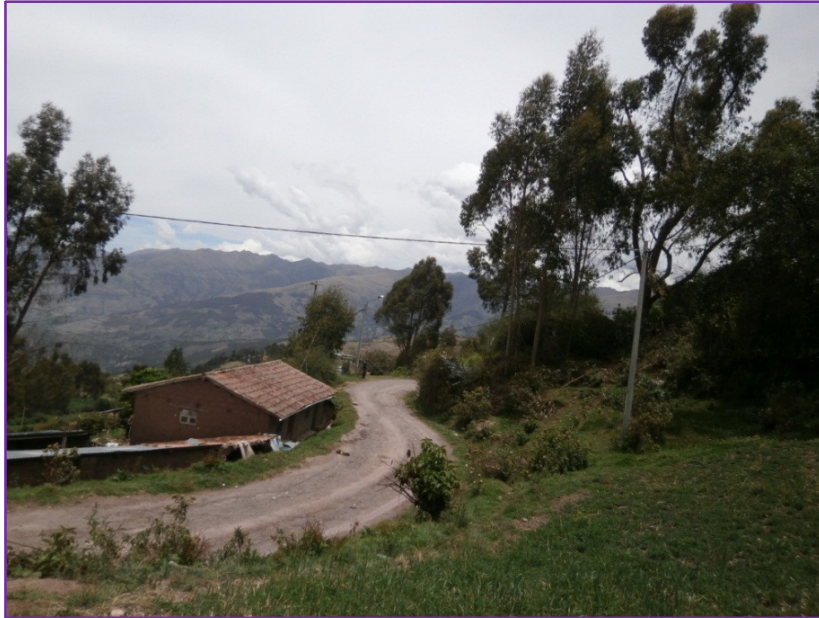
Fotografía 3. Camino vecinal en la progresiva KM 01+200 Fuente: Elaboración Propia
