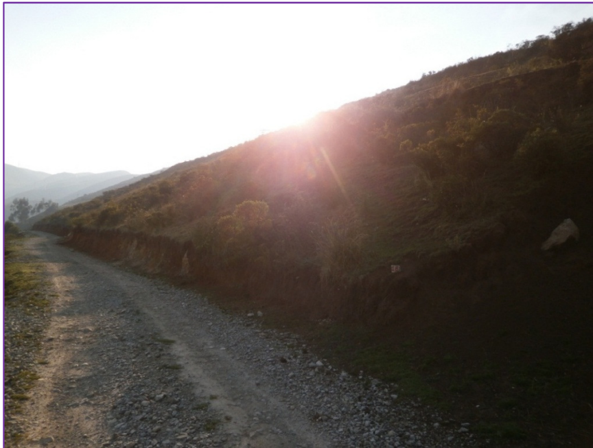
Fotografía 11. Camino vecinal en la progresiva KM 06+180 Fuente: Elaboración Propia
