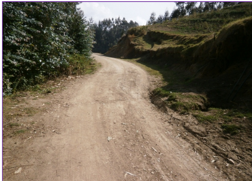
Fotografía 16. Camino vecinal en la progresiva KM 10+500
