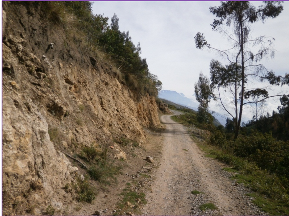
Fotografía 13. Camino vecinal en la progresiva KM 07+500 Fuente: Elaboración Propia
