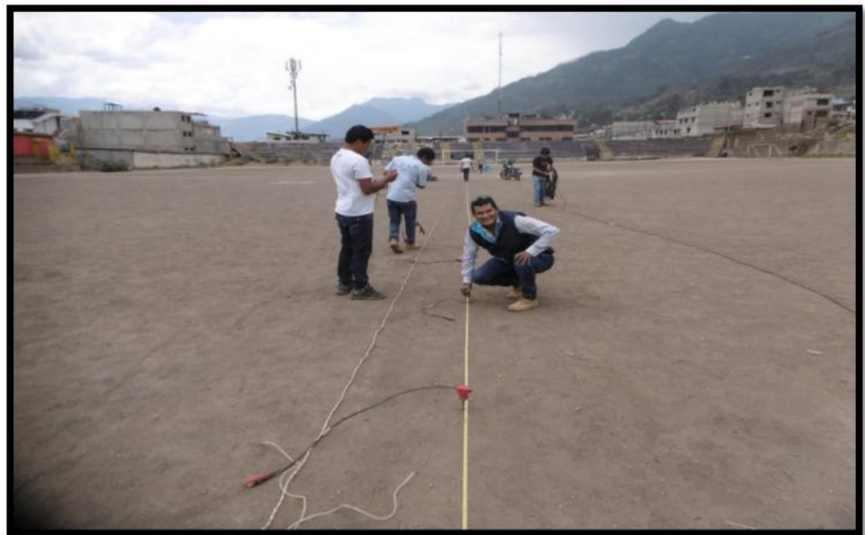
Figura N°4.16: Instalación de los geófonos.
