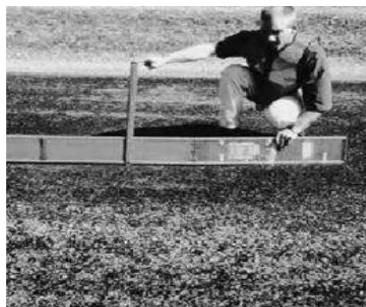
Depresión – Baja Severidad
