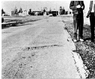
Abultamientos y Hundimientos – Media Severidad
