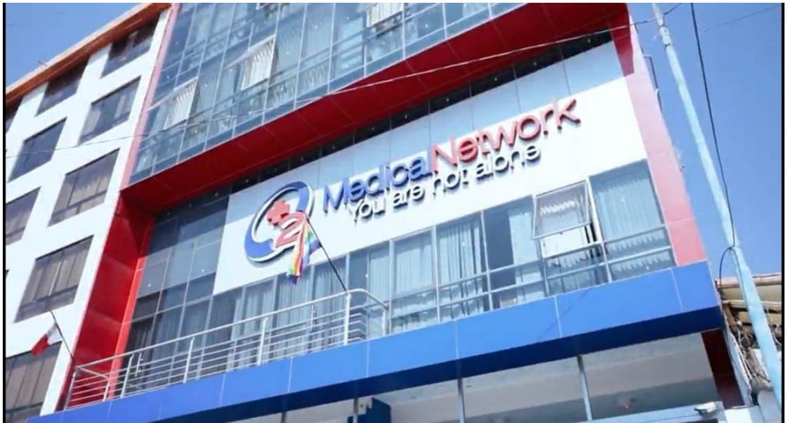
Infraestructura de la clínica O2 Medical Network Cusco
