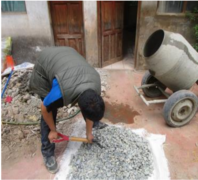
preparación del concreto
