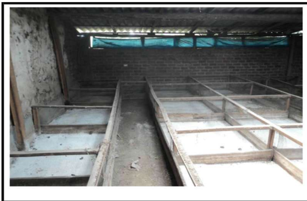
FOTO N° 01 DESINFECCION DEL GALPON
