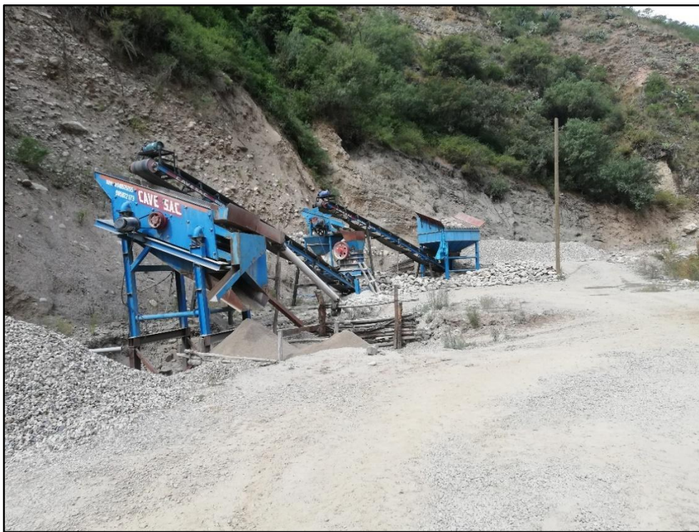
FIGURA 2: Máquina Chancadora utilizada para proceso de trituración
