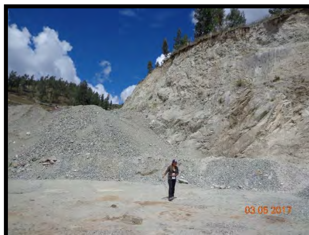
Ilustración 4-4 Excavación a Cielo Abierto
