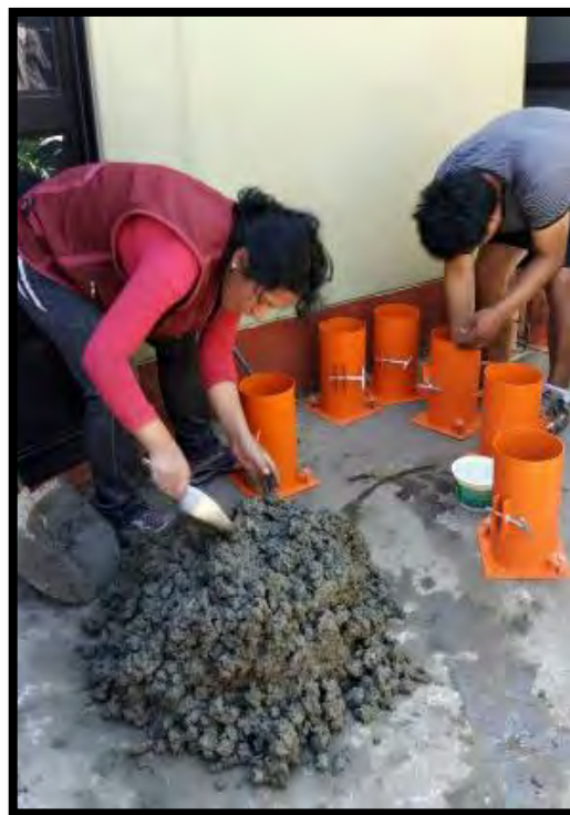
Ilustración 4-48 Elaboración de testigos de concreto
