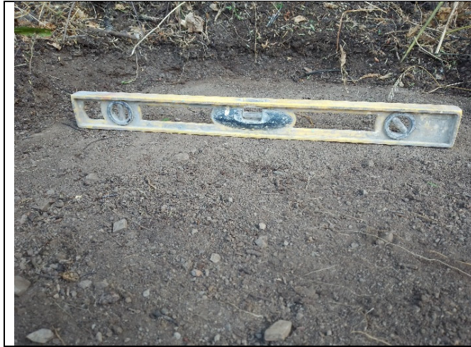
Nivelación del terreno para la prueba de infiltración básica - Prueba infiltrómetros doble anillo
