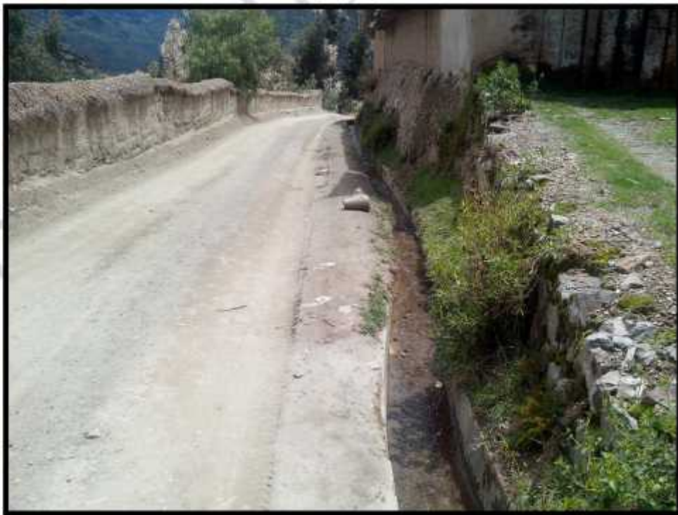
Foto N° 02: Se observa canal de evacuación de aguas pluviales existente
