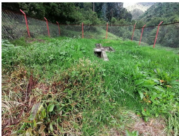
Valla perimetral de la planta depuradora de Pucyura
