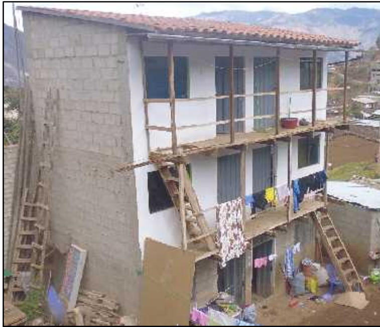
Figura 5.16: Vivienda con cobertura liviana y vigas de madera.
