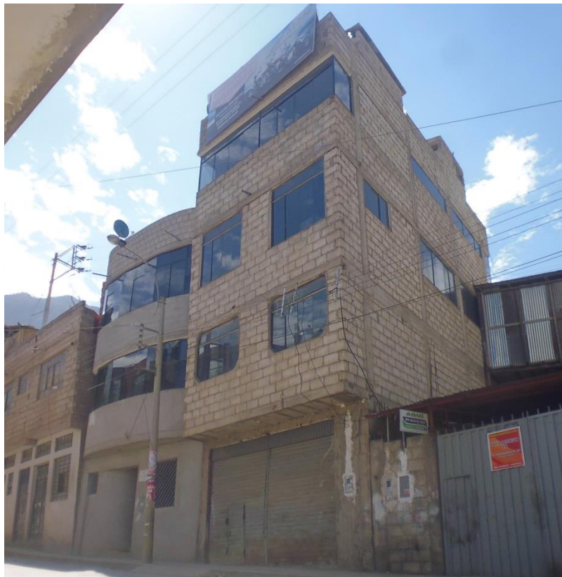
FOTO D-38: Se observa la fachada de la vivienda, con presencia de empuje de tierra.
