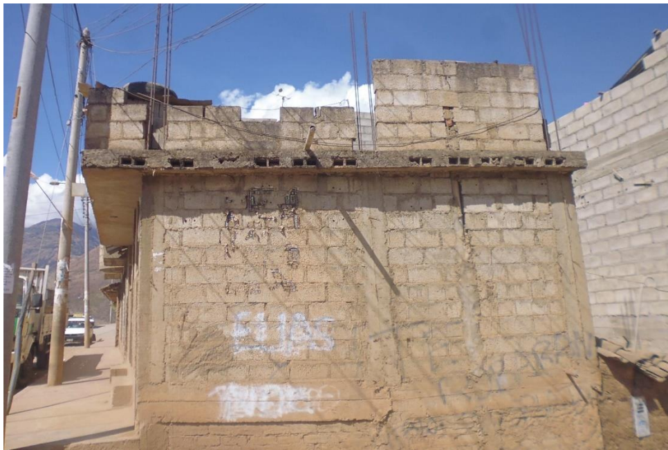
FOTO D-13: Se observa la vivienda con diferentes problemas en proceso de construcción.
