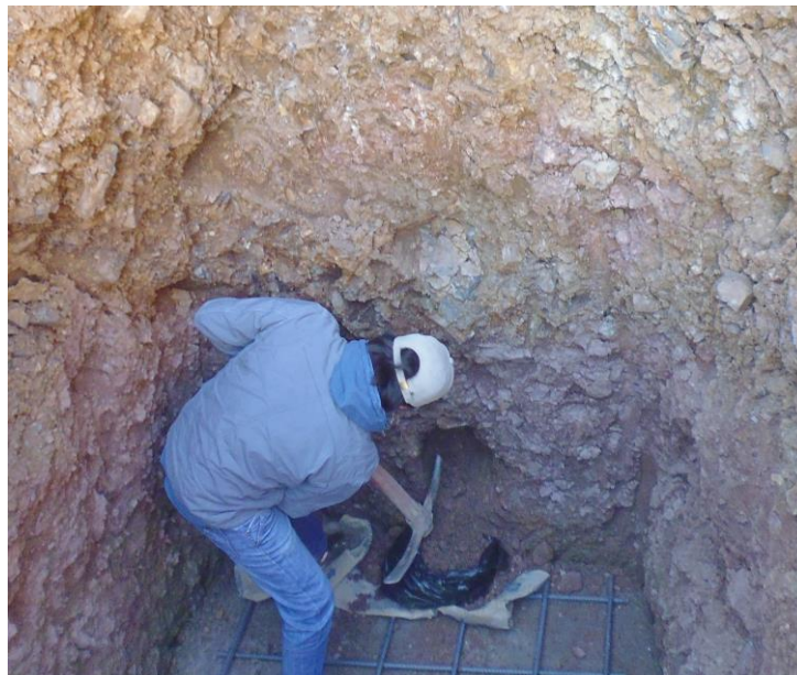
Foto A-2. La calicata Bella vista baja, extracción de muestra de suelo, se encuentra un suelo granular consistente en Arena Limosa, Arcillosa, con presencia de Grava, de color marron rojizo oscuro (SM-SC).
