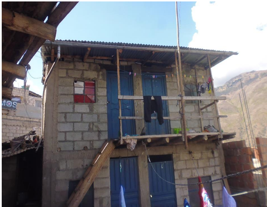
FOTO D-12: Se observa la fachada
