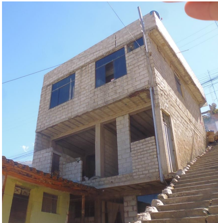
FOTO D-29: Se observa la vivienda, con empuje de tierra, deficiencia en la distribución de masas.
