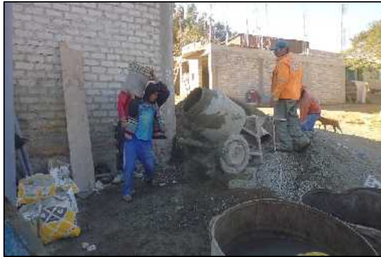
Figura 6.14: Concreto para columna preparado In situ.
