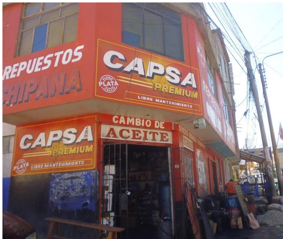
FOTO D-40: Se observa la fachada de la vivienda.
