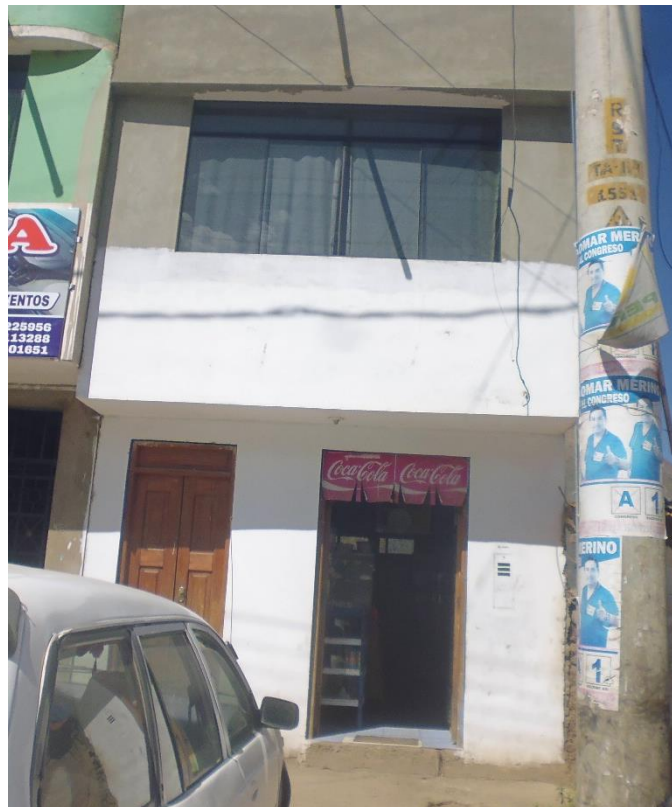
FOTO D-42: Se observa la fachada de la vivienda.
