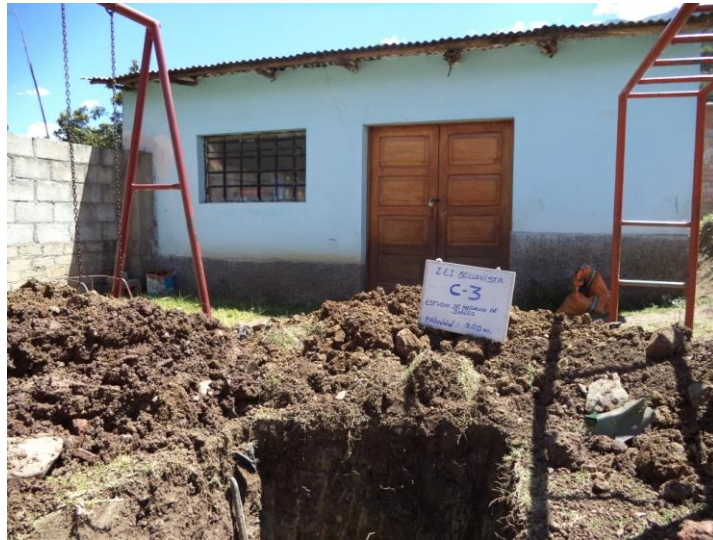
Foto A-9. La calicata 03 se ubica en la parte frontal de un ambiente que se usa como almacén
