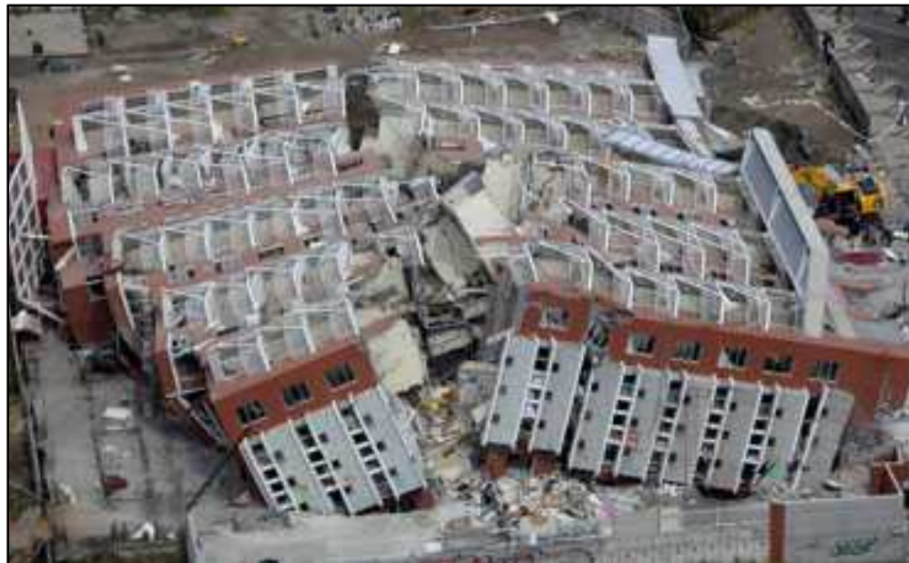
Figura 3.18.- Daño observado en las edificaciones luego del terremoto de Chile del 27 de febrero del 2010.
