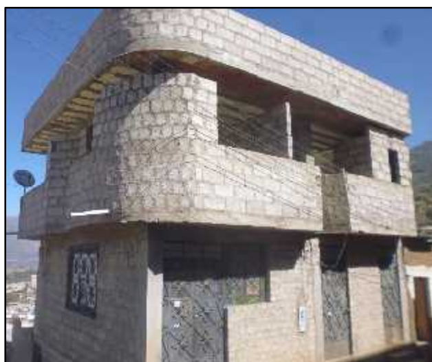
Figura 5.30: Edificación de albañilería con parapetos no confinados.
