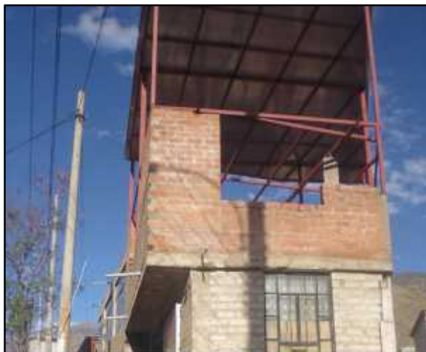
Figura 5.29: Techo de acero colocado en la azotea de la edificación.
