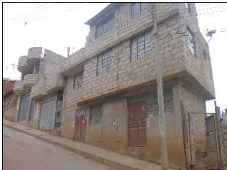
Figura 5.14: Edificación ubicada sobre terreno con gran pendiente.
