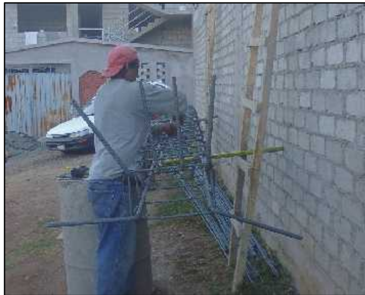
Figura 7.21: Armado de las columnas
