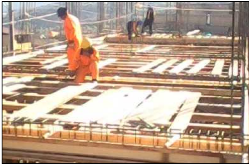
Figura 7.31: Encofrado de losa aligerada
