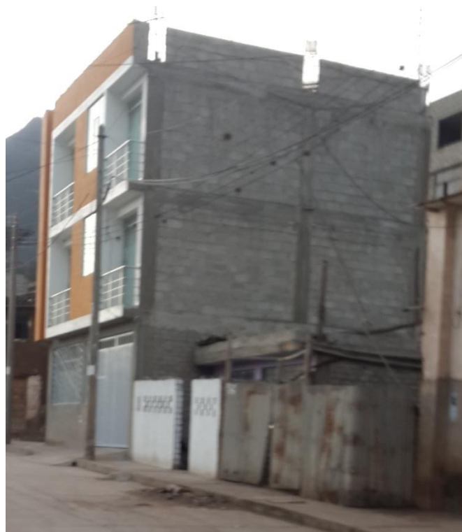
FOTO D-25: Se observa la fachada de la vivienda, con estado de conservación buena.
