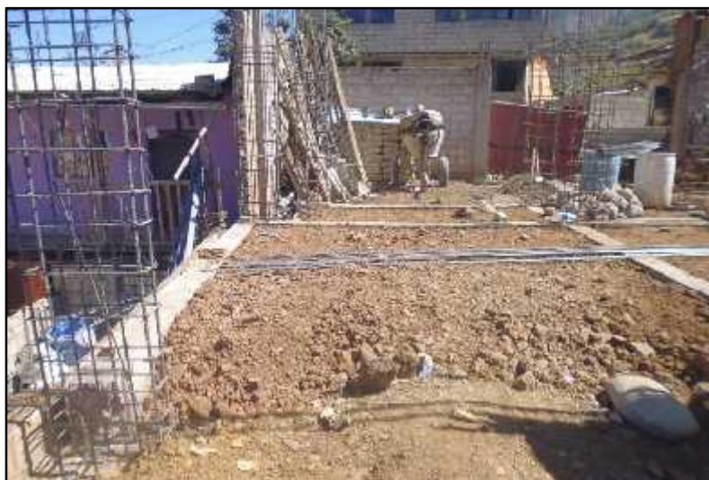
Figura 6.1: Vivienda sobre relleno no controlados
