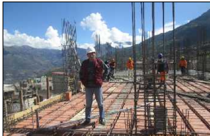
Figura 7.33: Proceso de llenado de la losa aligerada
