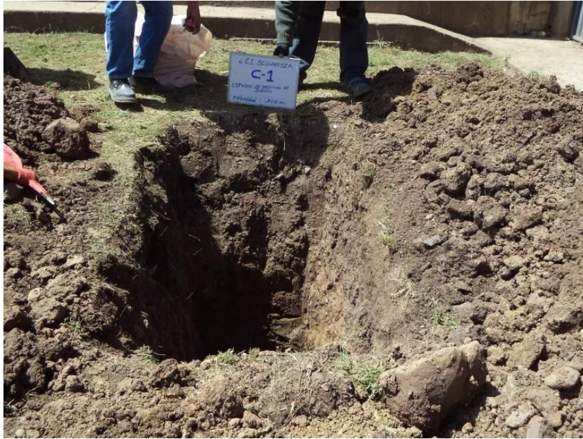
Foto A-5. La calicata C-1 fue ubicada en la margen izquierda del portón de ingreso a la institución Educativa I.E.I. N° 145 Bellavista
