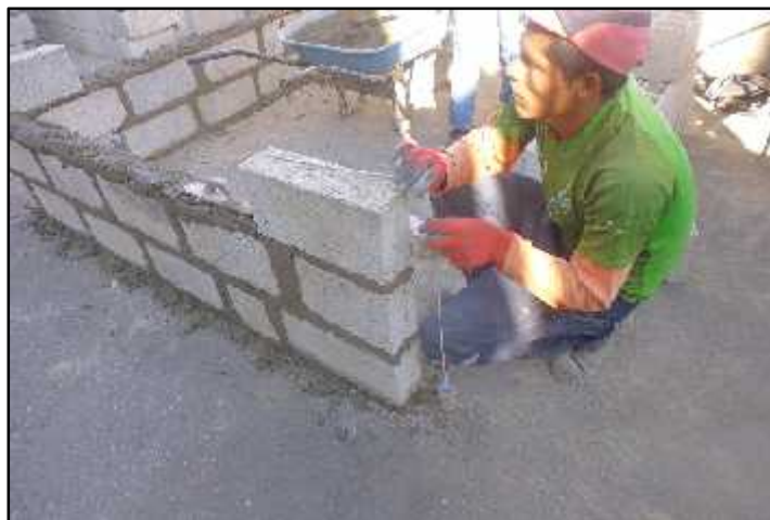
Figura 7.18: Construcción de muros de ladrillos
