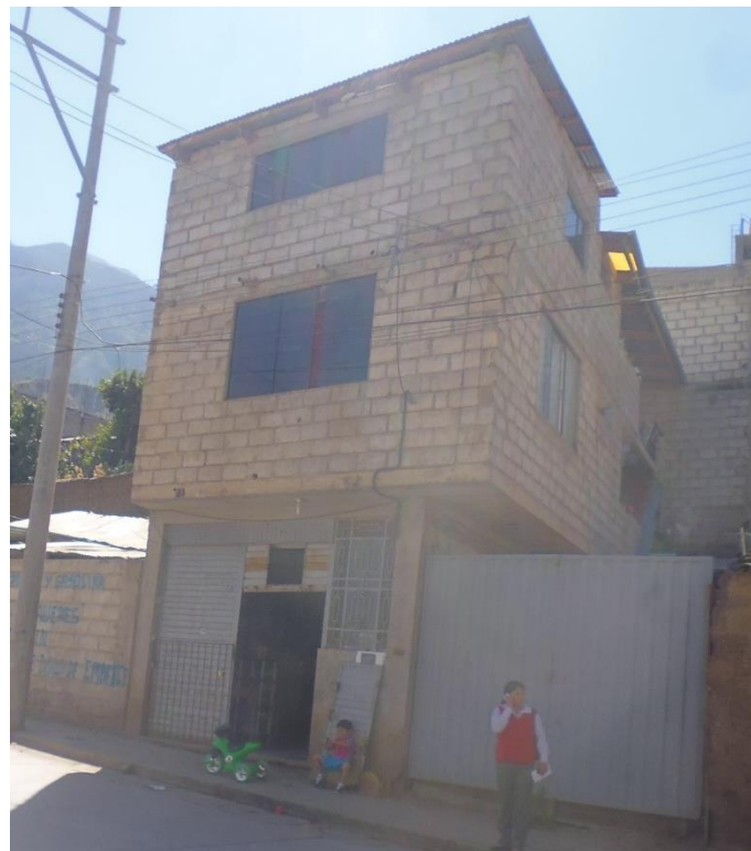
FOTO D-27: Se observa la fachada de la vivienda, con deficiente distribución en planta.
