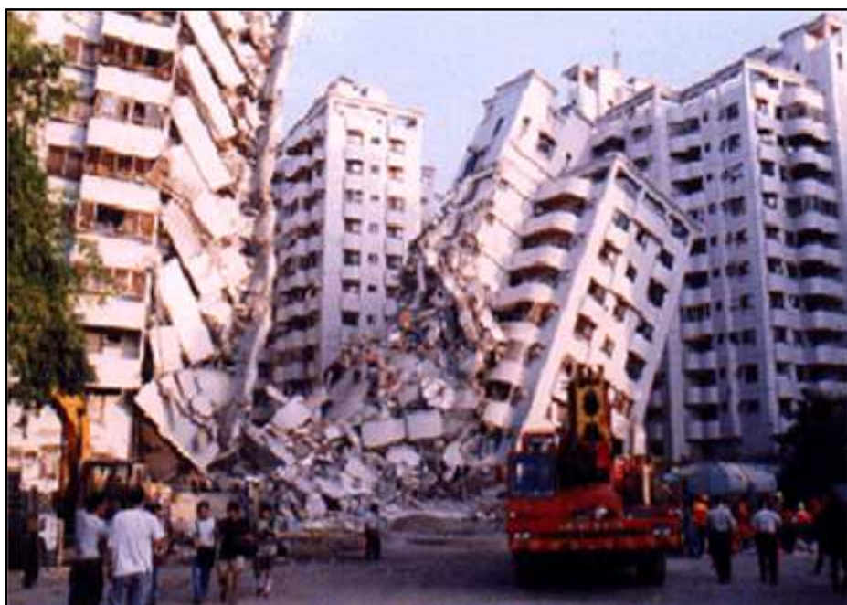
Figura 3.20.- Daño observado en las edificaciones luego del terremoto de Turquía del 23 de octubre del 2011.
