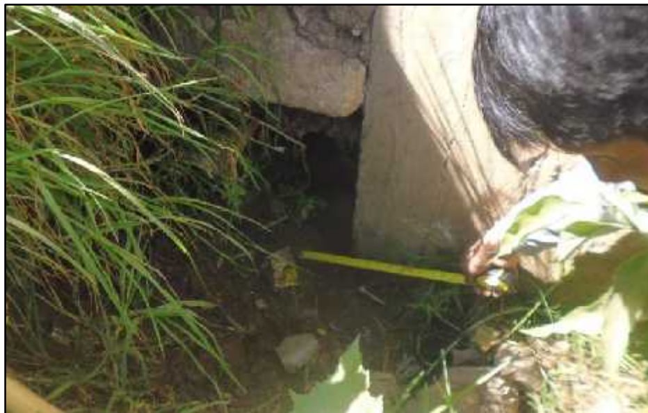
Figura 5.12: Edificación con presencia de humedad en el sobrecimiento, muros y columnas.
