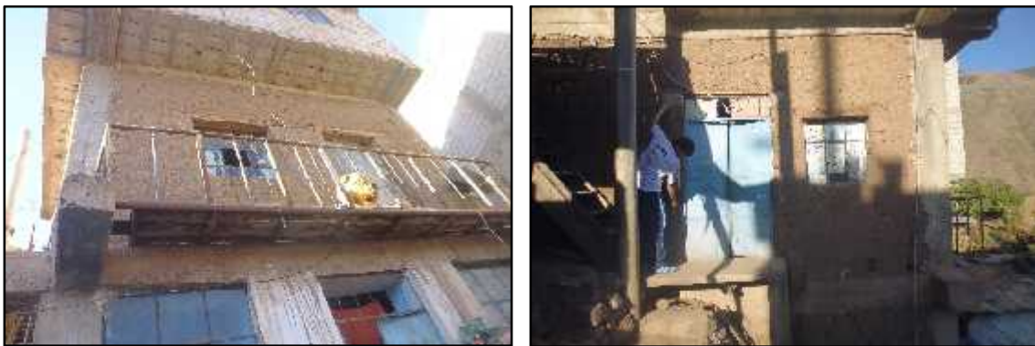
Figura 6.18: Muros portantes de adobe
