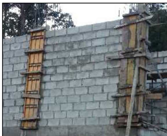
Figura 7.22: Encofrado de columnas
