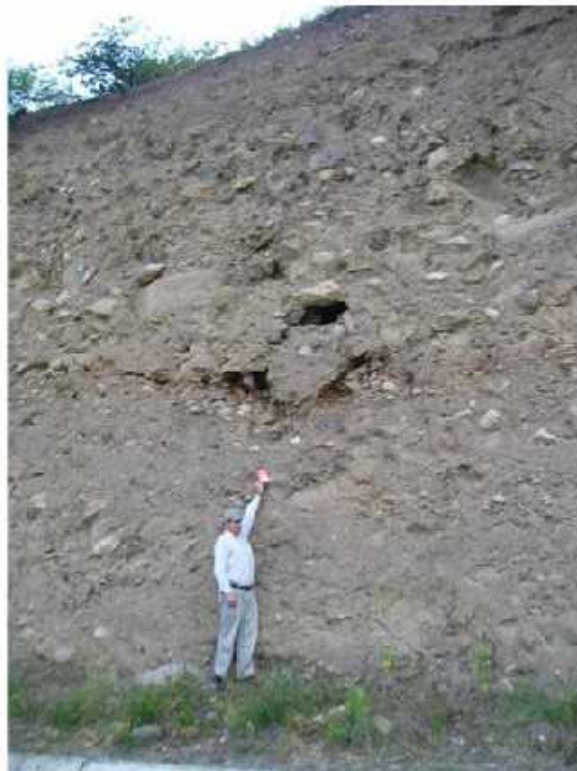
Figura 2.8: Vista fotográfica del depósito coluvial en la corte de talud de carretera. Fuente: Programa Ciudades Sostenibles-Abancay (2007)
