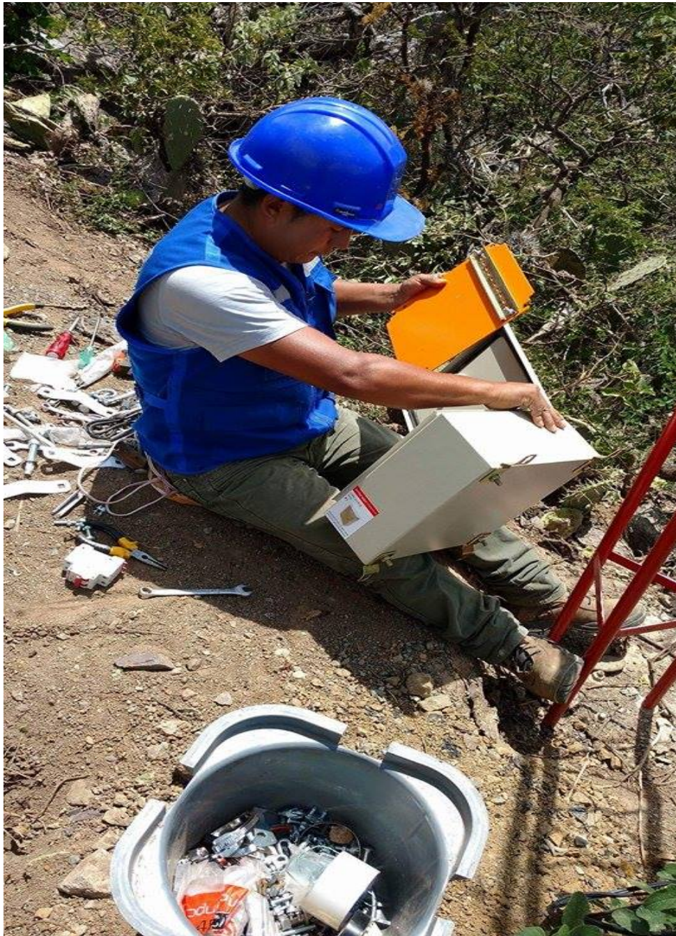
Fotografía 6: Habilitación de la caja de control
