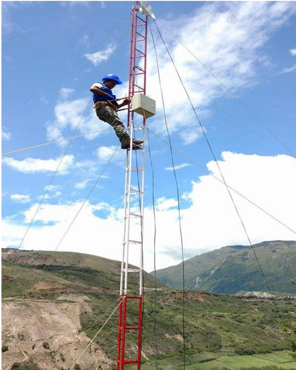
Fotografía 5: Instalación de la antena repetidora
