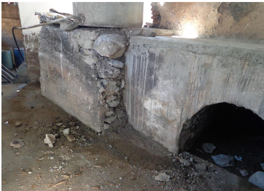
Foto N° 02. Sala de destilación antes de la adecuación
