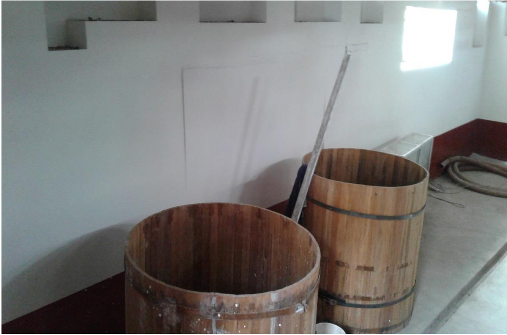
Foto N° 05. Sala de Fermentación después del estucado
