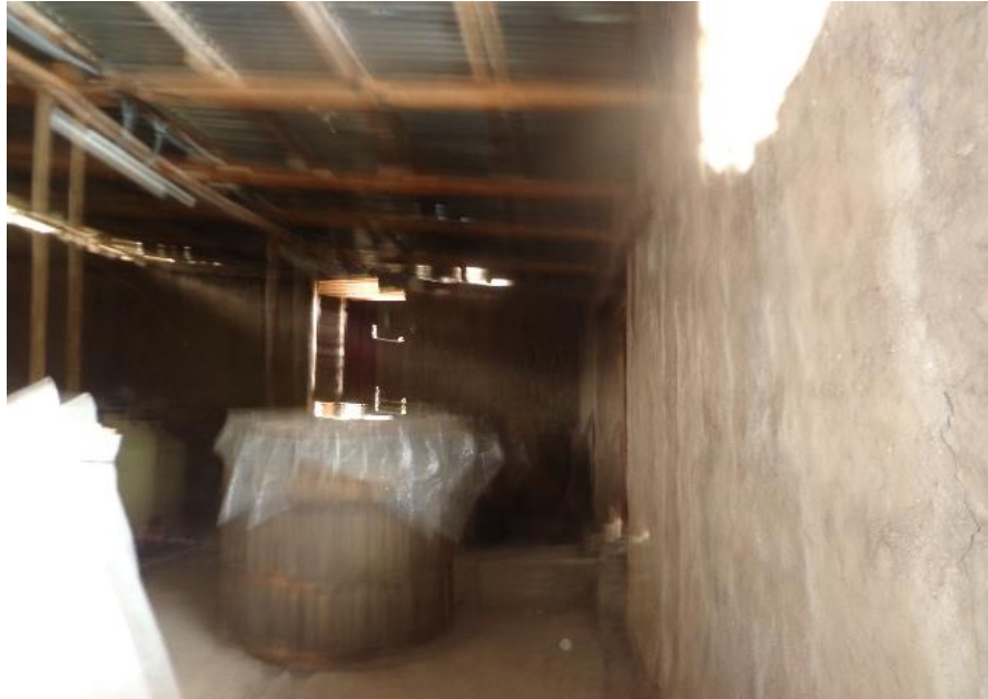
Foto N° 01. Sala de fermentación antes de la adecuación
