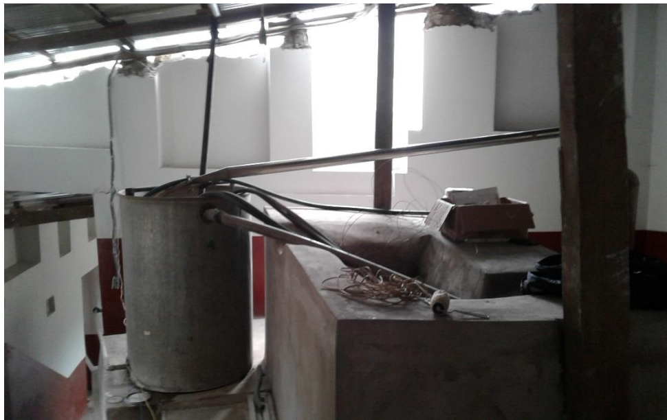
Foto N° 04. Sala de destilación después del estucado
