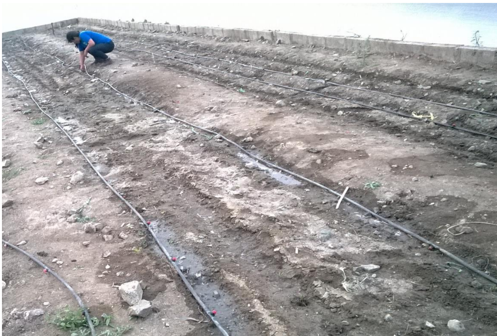
Foto N° 04. Instalación de sistema de riego en la parcela experimental
