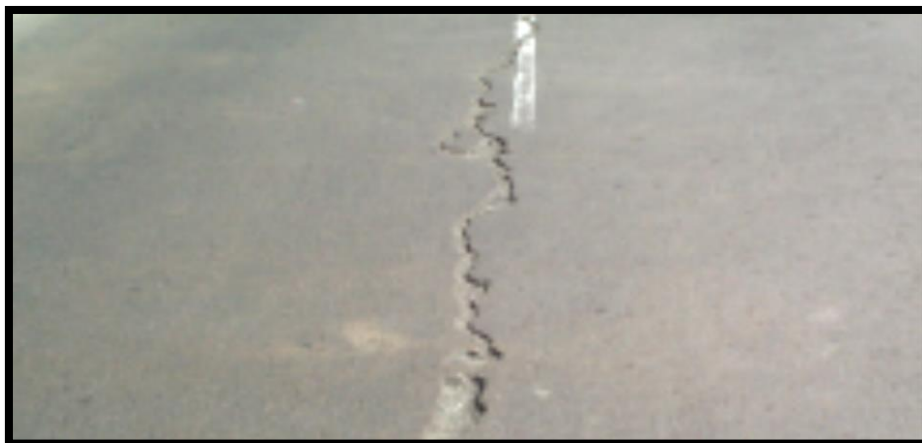
Fisuras longitudinales
