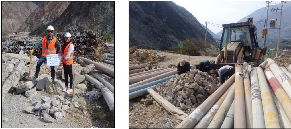
Figura 2. Procesamiento de bloques de concreto, para su posterior triturado en la chancadora.
