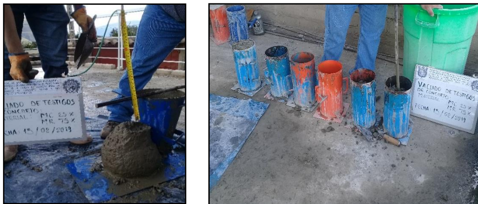
Figura 26. Elaboración de concreto y moldeado de briquetas.
