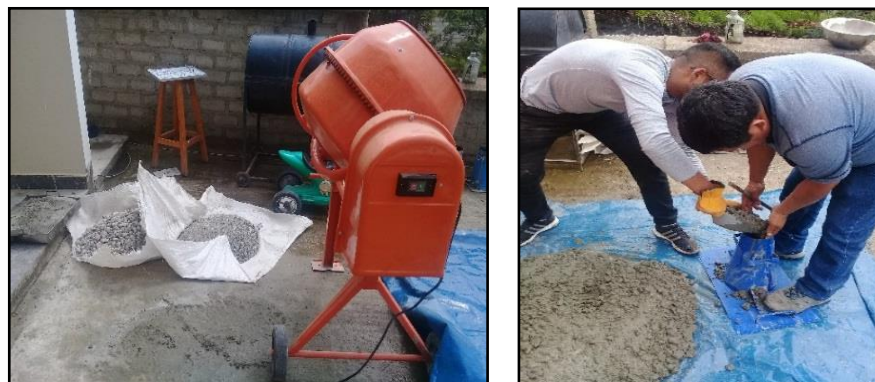
Figura 22. Proceso de mezclado y prueba de cono de Abrams del concreto.
