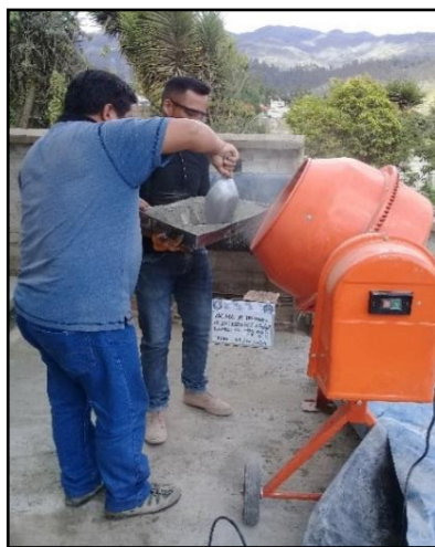
Figura24 .Elaboración de concreto y prueba de cono de Abrams para asegurar el slump.
