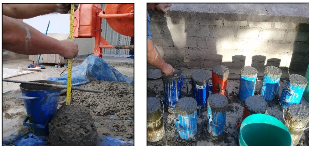
Figura 27. Concreto fresco, enrasado de moldes.
