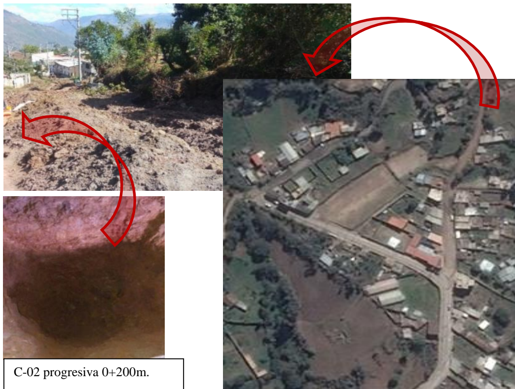
Figura 12: Localización de la calicata N°2 en la vía en estudio.
