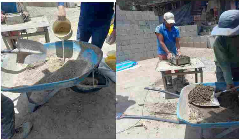
Nota. Mezclado y moldeado de bloques.
