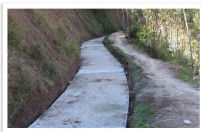
Fotografía N° 03: Canal Mariño – Conducto cubierto con tapas de concreto – Sector Aymas
