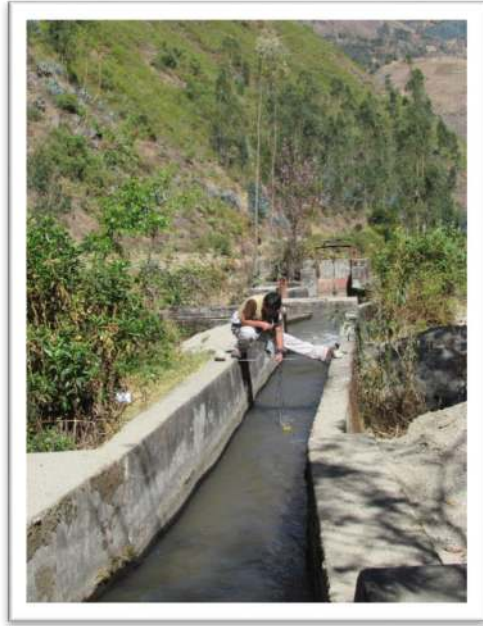
Fotografía N° 10: Canal Mariño – Registro de aforo – Sector Puruchaca
