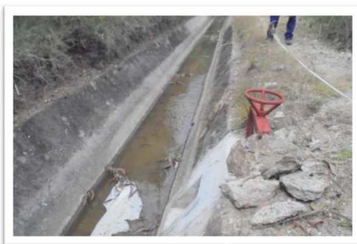
Fotografía N° 05: Canal Mariño – Tramo en concreto – Sector Aymas
