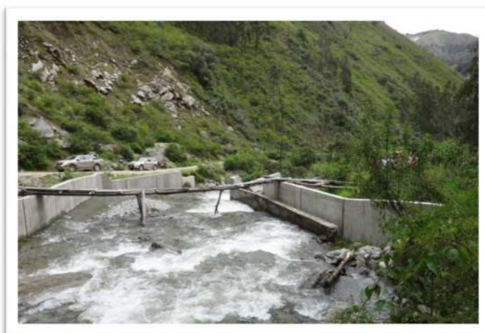
Fotografía N° 06: Canal Mariño – Captación Puruchaca – Sector Puruchaca
