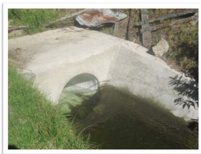
Fotografía N° 09: Canal Mariño – Inicio de conducto cubierto con tubería – Sector Calabazapata
