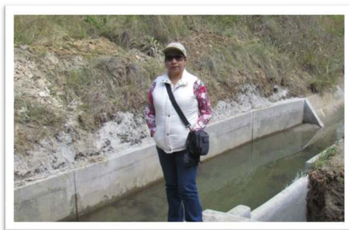
Fotografía N° 08: Canal Mariño – Desarenador – Sector Aymas
