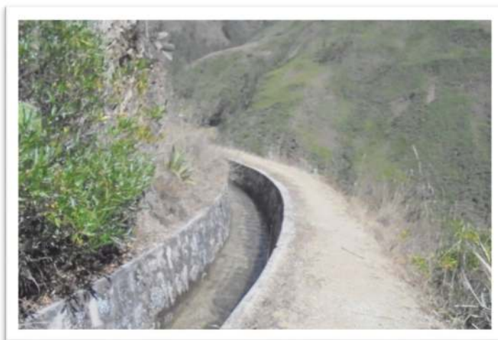
Fotografía N° 04: Canal Mariño – Tramo en mampostería en piedra – Sector Aymas
