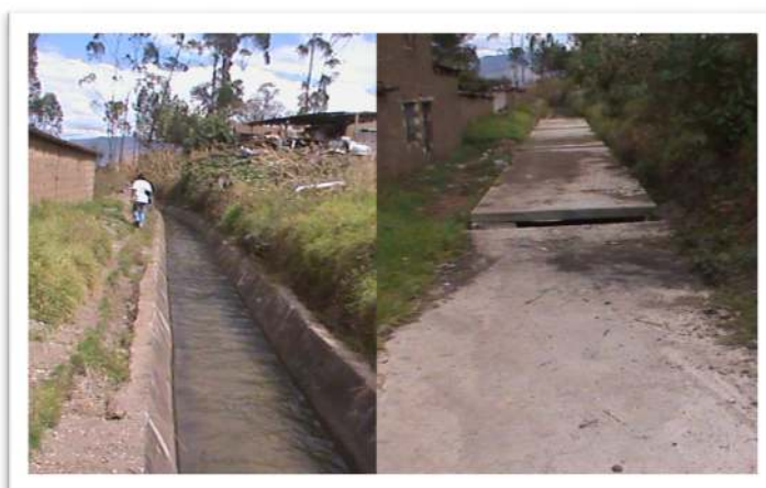
Fotografía N° 02: Inventario y verificación de infraestructura de riego – Sector Tamburco
